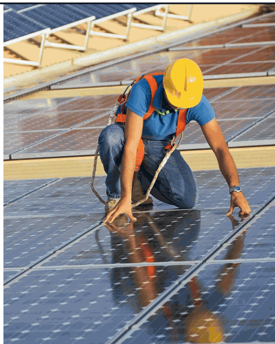
▲ Pannelli sui tetti Dal sole energia alternativa per la città del futuro
